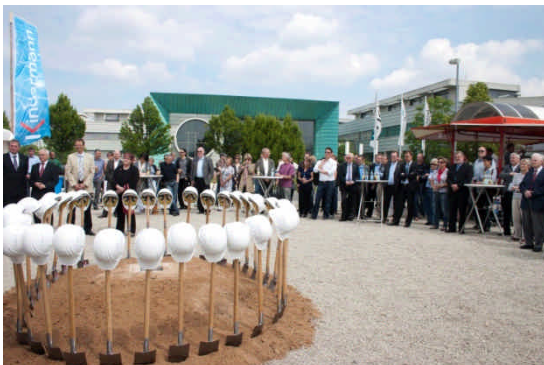
Grundsteinlegung und Spatenstich _28.05.2011 (9)
